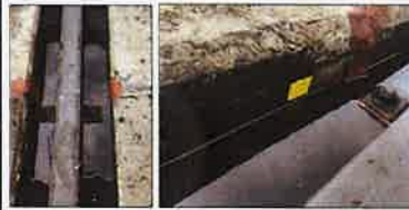
รูปที่ 6 การแก้ไขรอยรั่วซึมบริเวณท่าเรือขนถ่ายถ่านหินของโครงการ
