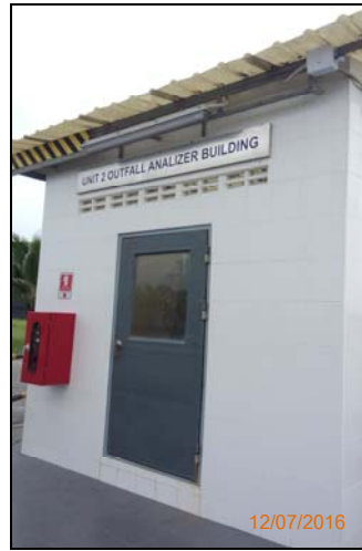
ห้องควบคุมการตรวจวัดคุณภาพน้ำบริเวณ คลองระบายน้ำหล่อเย็น หน่วยที่ 2
