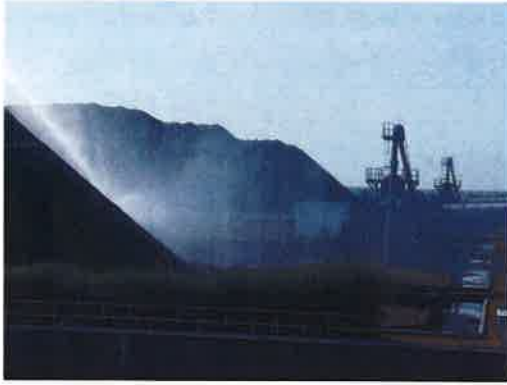
รูปที่ 2 การฉีดพรมน้ำบริเวณลานกองถ่านหิน และสายพานลำเลียงถ่านหิน
